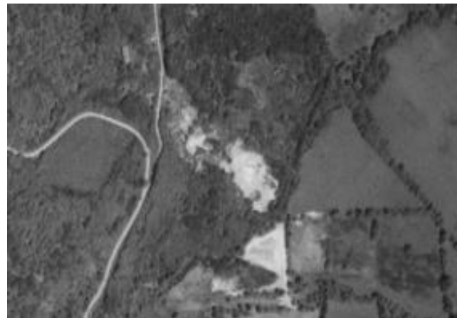
1969 : l'étang semble en cours de terrassement
